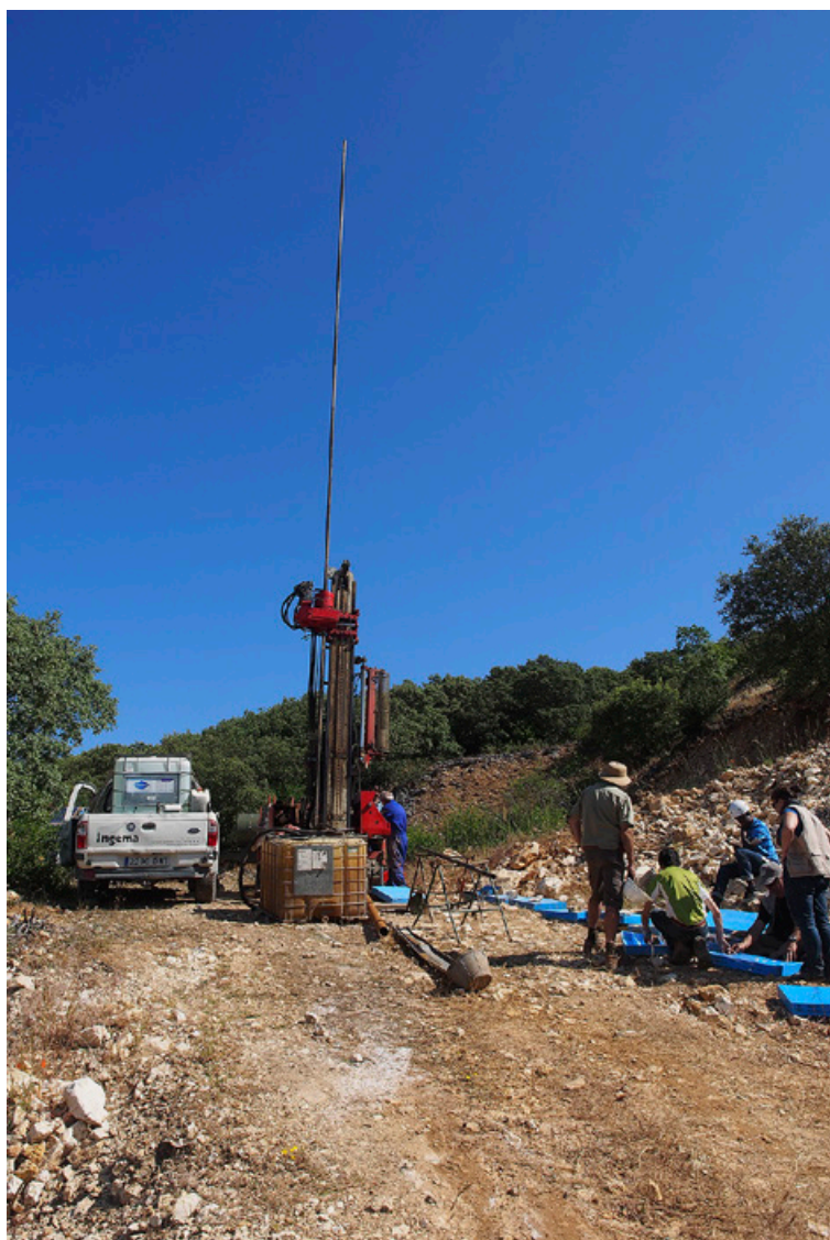
Perforación con recuperación de testigo sobre una cavidad detectada al SE de Dolina. FOTO: Ana Isabel Ortega
